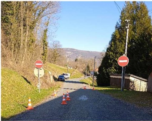
28/02/2022 Test circulation du futur aménagement RD 16 Route de Vanchy
